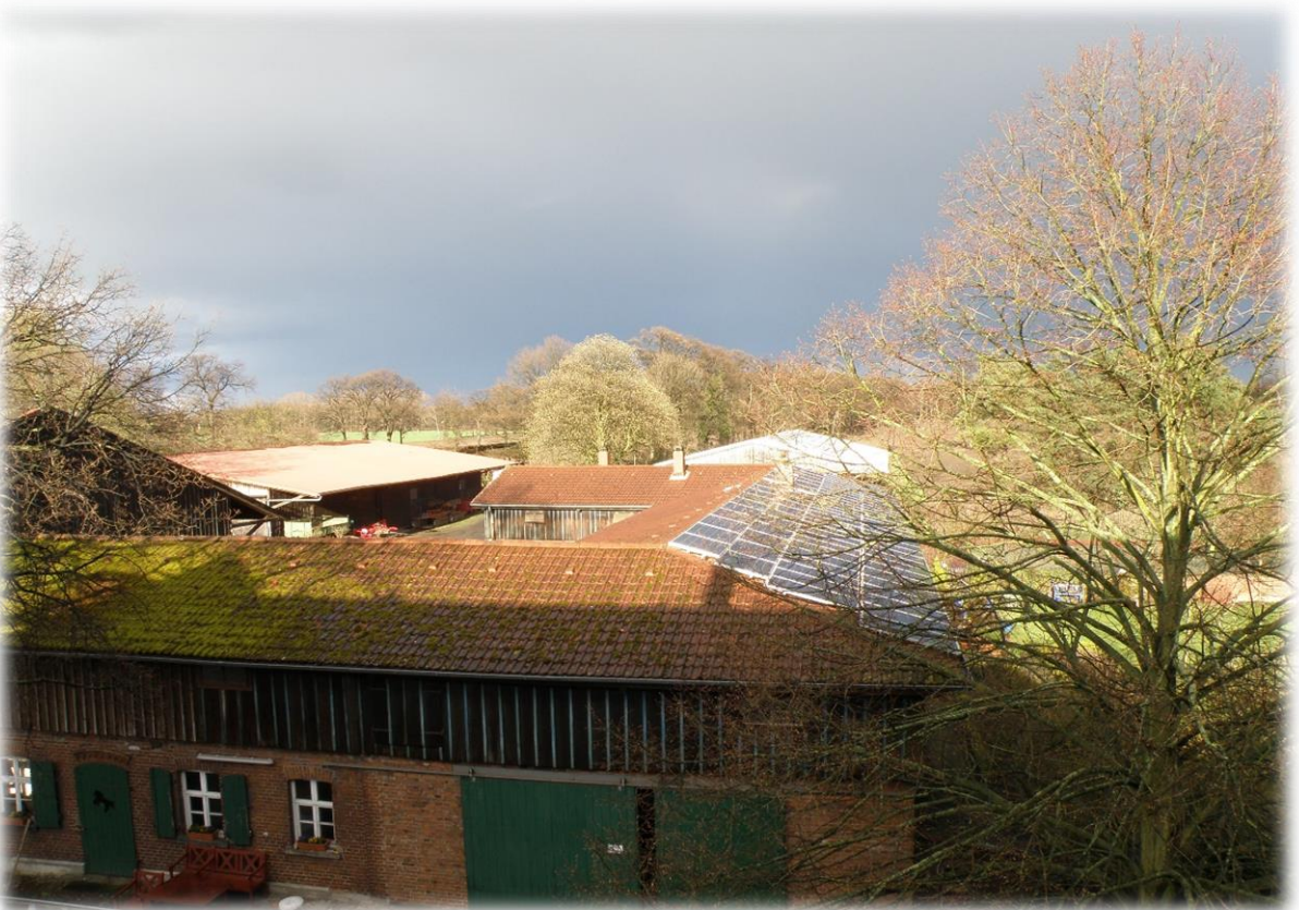
Blick über die Hofgebäude, der alte Pferdestall im Vordergrund
